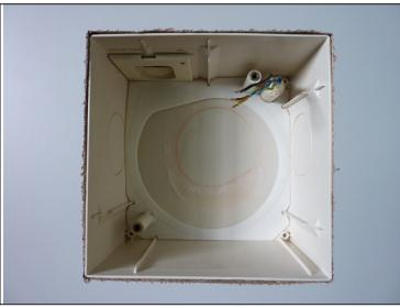
3. Insérez le joint fourni au fond du boîtier. Respectez les arêtes de guidage du joint.
