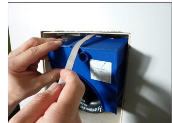
4. ER-A, ER-AK, ER-AH, ER-AB : visser le cache de protection avec l'insert de ventilateur à l'aide de la vis centrale fournie du kit ER EC RF17. Avec le montage mural, l'emblème de la marque Maico doit se trouver en bas à droite.
